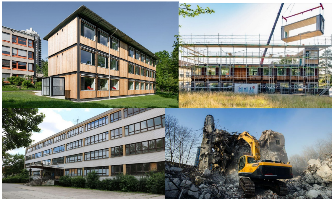
Abbildung 4: Modularer Schulbau unter Berücksichtigung der Holzbauweise als Beispiel Zirkulären Bauens (oben) vs. Plattenbauweise (unten)
